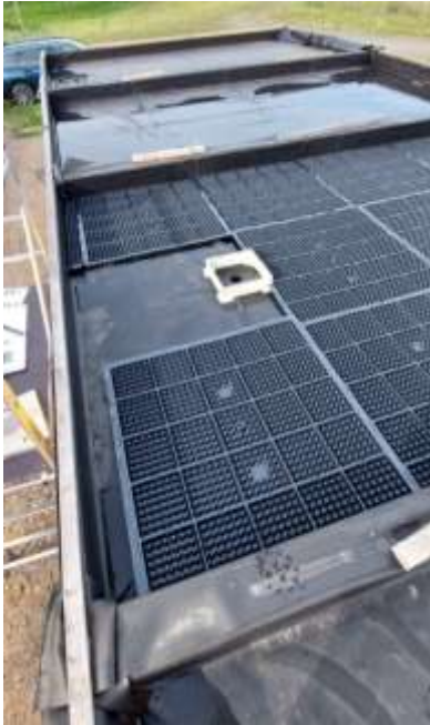
Auslegen des Drainage- und Speichersystem.
