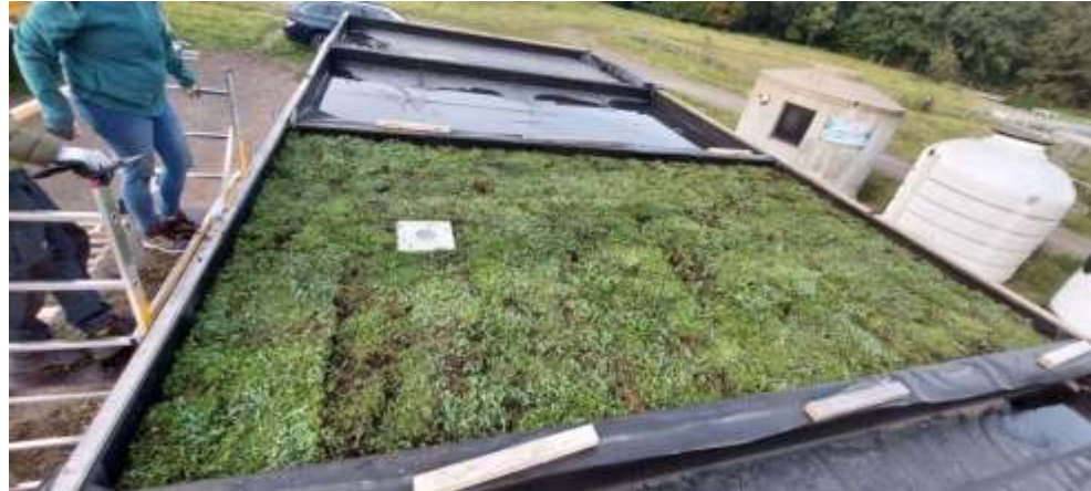
Fertigstellung des Daches.
