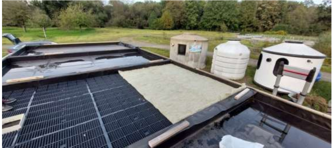
Auslegen des Green Roll Substrat (HTC GR)
